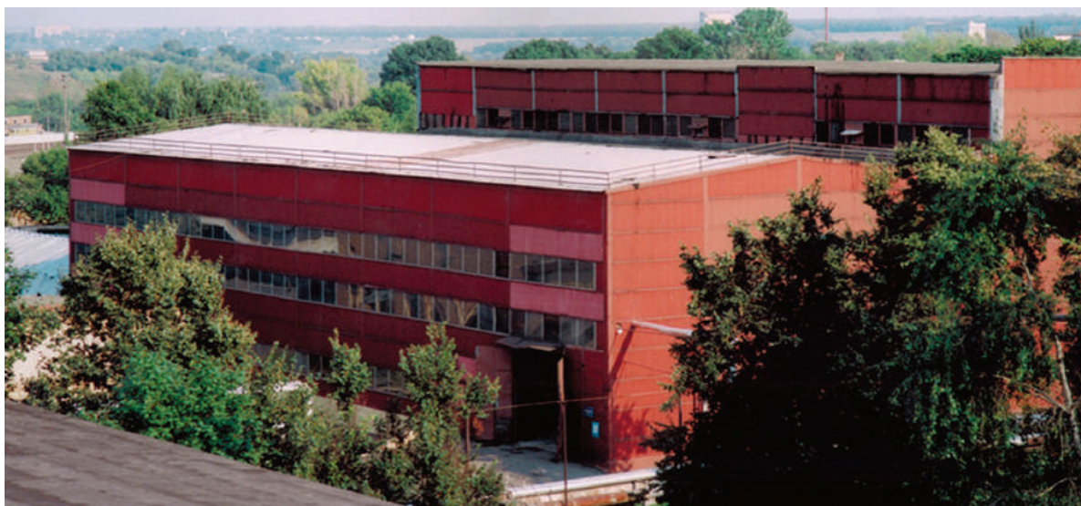
Завод в г. Щигры, Курская область.
